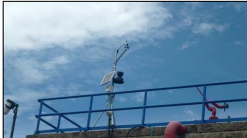
*Ilustración 1. Registro fotográfico estación meteorológica costera remota – incluye Sistema de Control - Anemómetro
