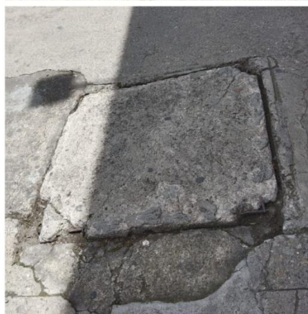
DEHIERVADO GENERAL DE ENTRADAS PRINCIPAL.N. OPERARIOS 2
