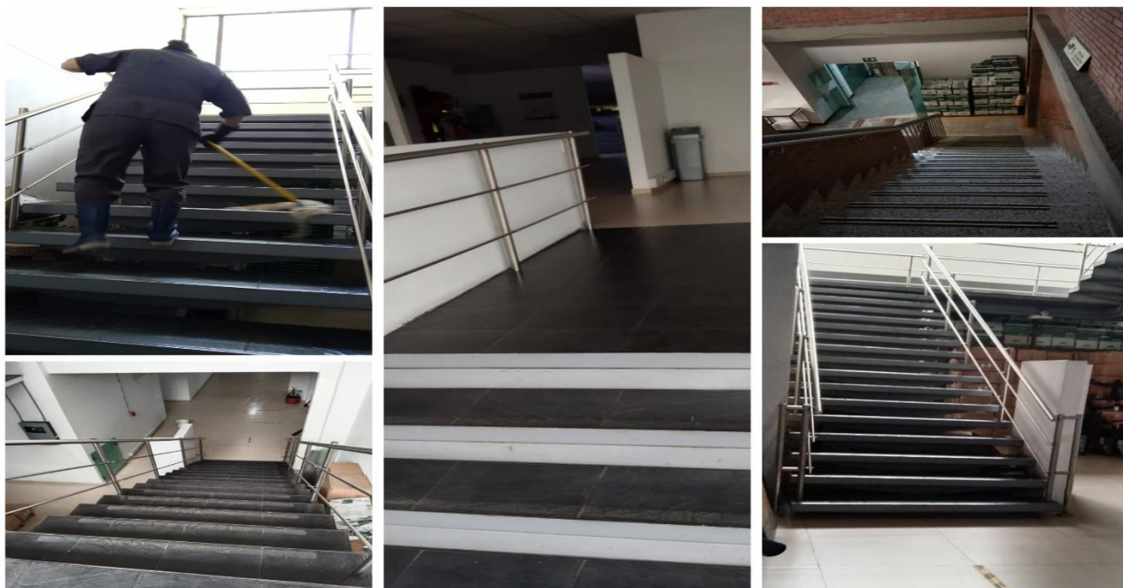
BRIGADA GENERAL DE ESCALERAS OPERARIO 1.
