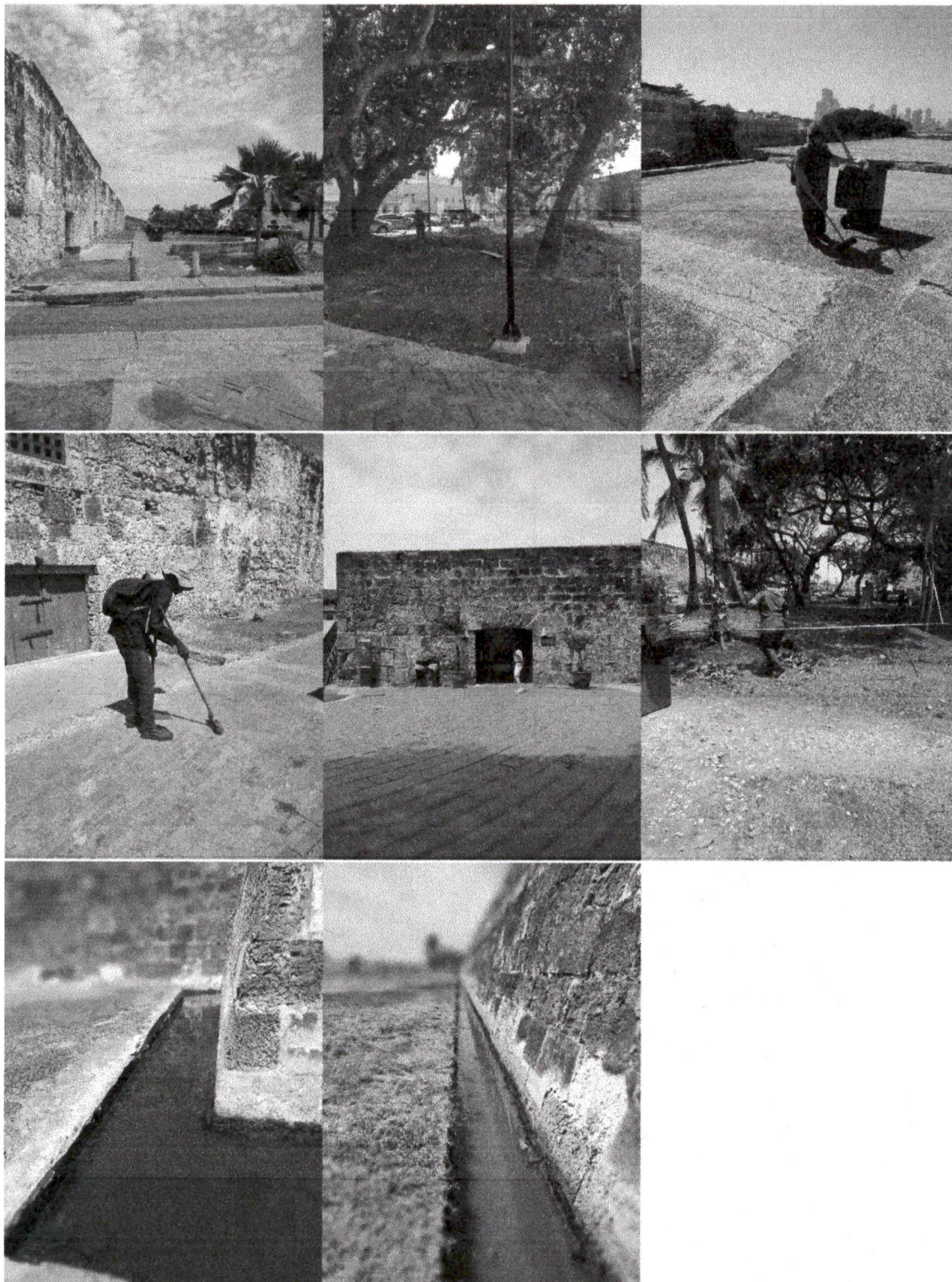
ACTIVIDADES DE LIMPIEZA - Cordon Amurallado Sector Torre del Reloj
