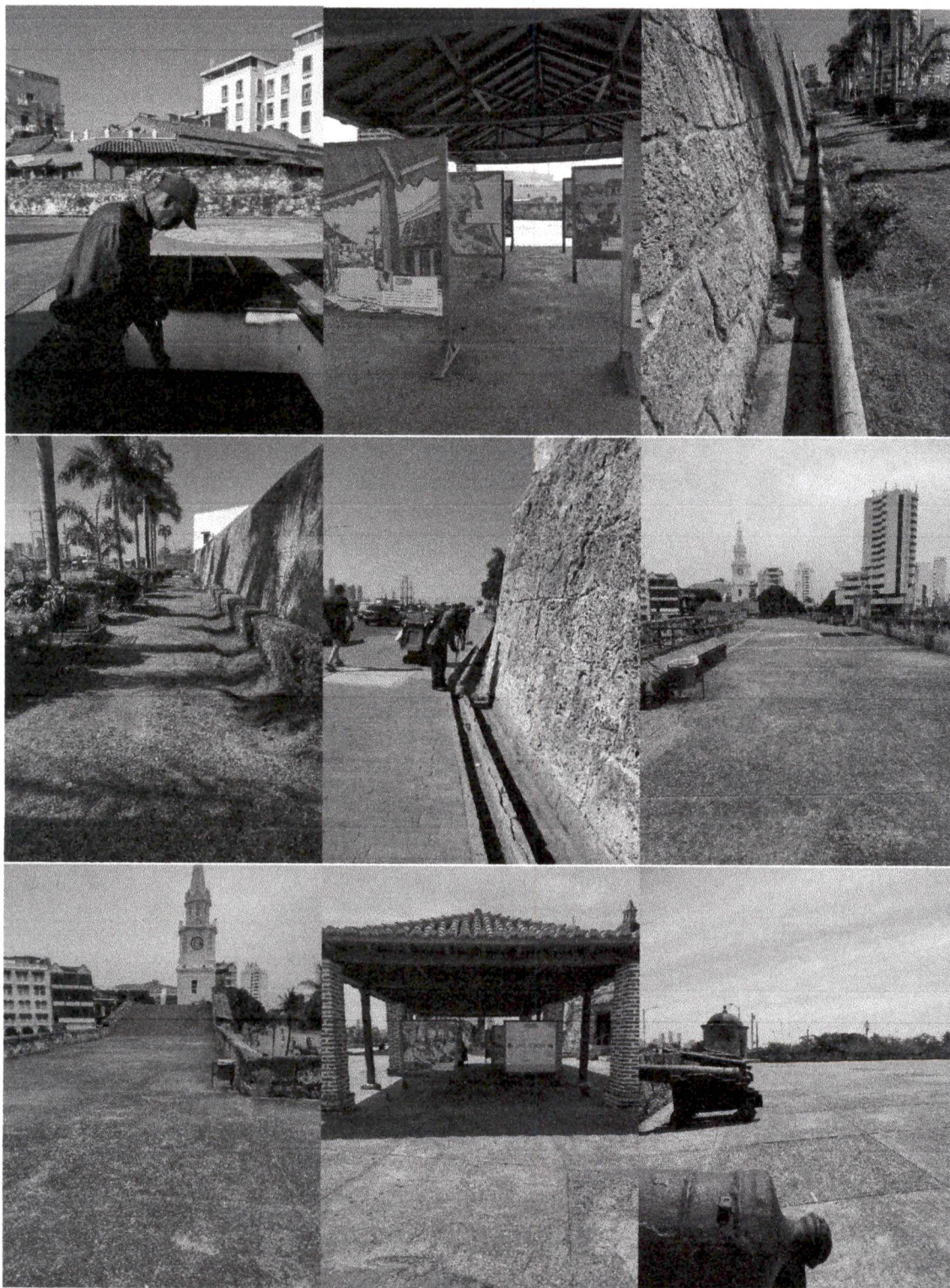
ACTIVIDADES DE LIMPIEZA - Baño de Chambacú
