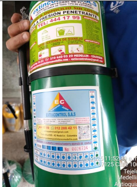
EXTINTOR DE AGUA DE 2 ½ GALONES
