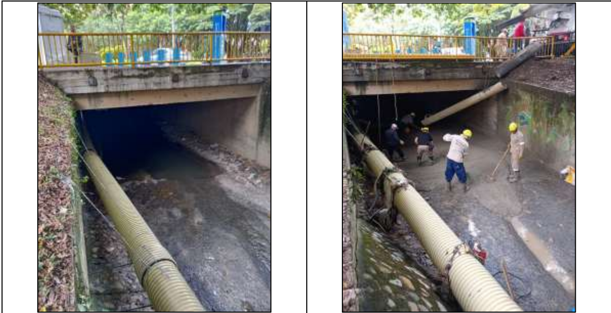
Ilustración 2. Mantenimiento losa de piso quebrada La Picacha. CL 32F 74B-06
