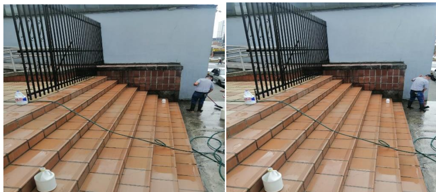
HIDRO LAVADO SEDE JUZGADOS PENALES Y SEDE ADMINISTRATIVA POR FUERA Y REDEDOR DE ESTE
