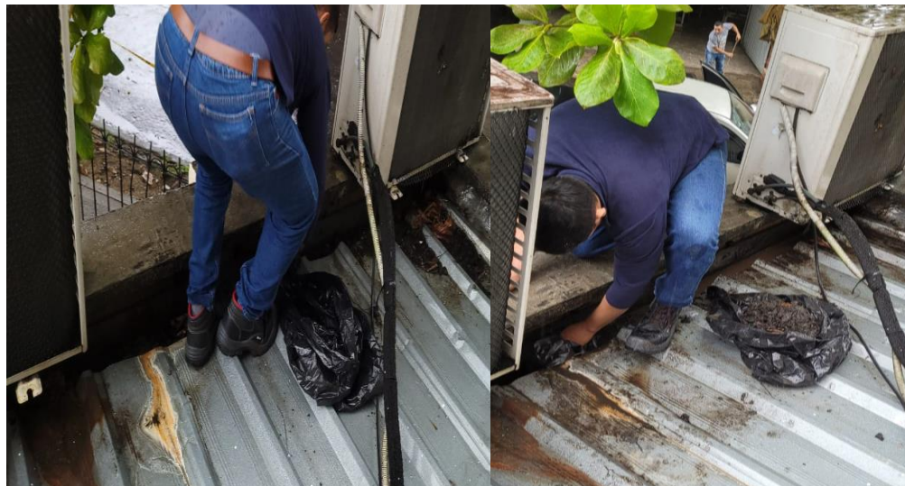
Se realiza mantenimiento y limpieza a desagües de Viga canal del palacio de justicia de Florencia Caquetá
