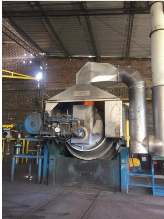
Horno rotativo basculante.
