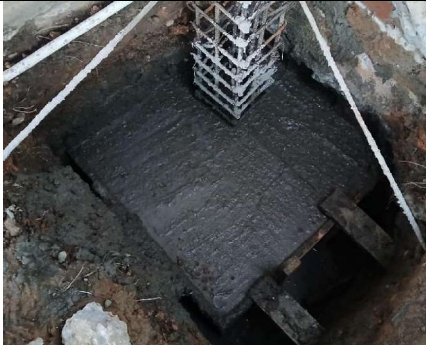
Fotografía N° 02: Zapatas en concreto reforzado e impermeabilizado F'c=3000 PSI según diseño estructural (Incluye vibrado y curado)
