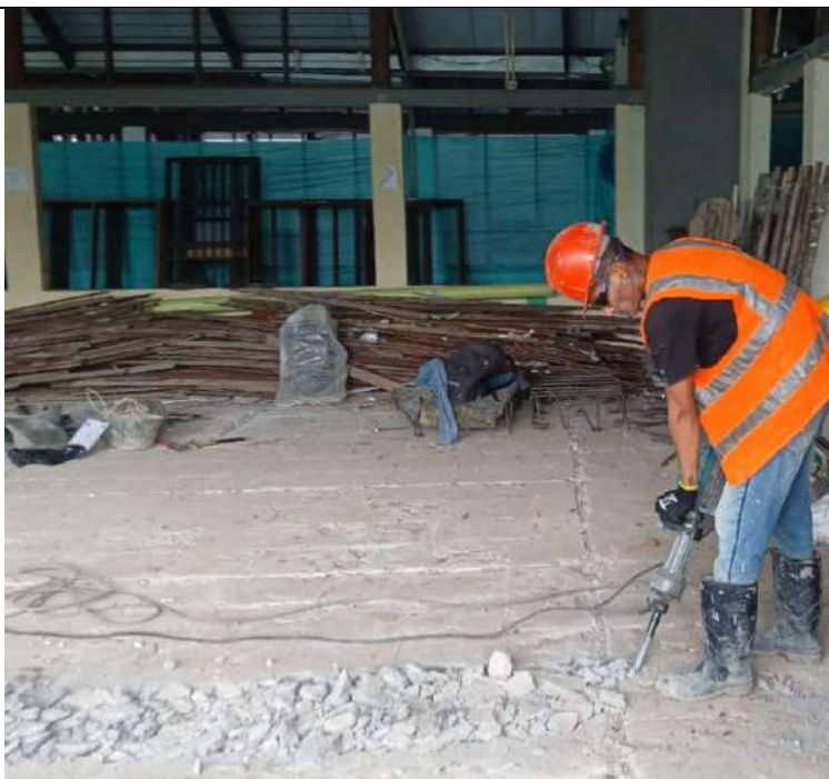
Fotografía N° 03: Demolicion de placa de contrapiso e=20 cm
