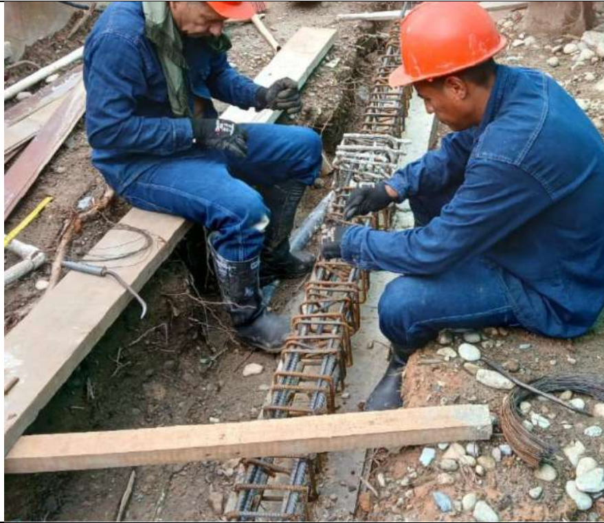
Fotografía N° 05: Suministro, figurado e instalación Acero de refuerzo
