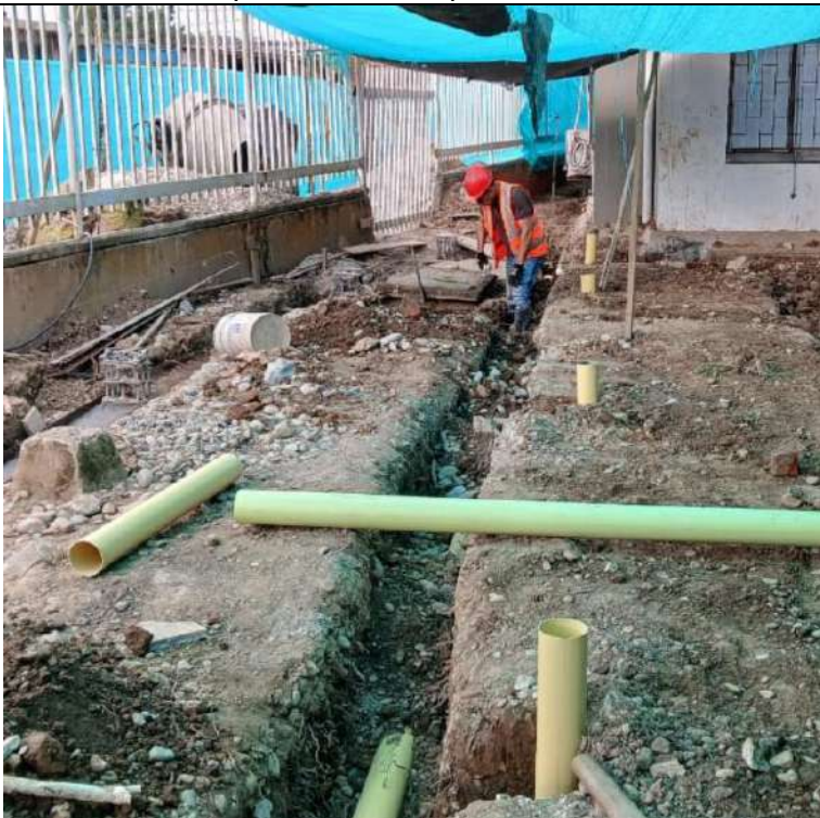
Fotografía N° 04: Suministro e instalacion de tuberia sanitaria de 3" (incluye excavacion y accesorios requeridos para su instalacion)
