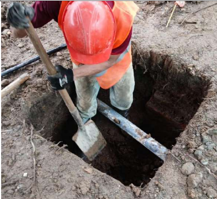
Fotografía N° 01: Excavacion manual para cimentacion H_{max}=1,8 m (según diseño estructural)
