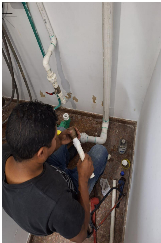
Reparación y mantenimiento tubería agua limpia.
