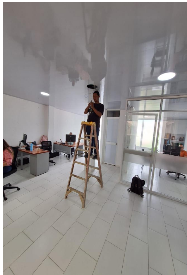
Cambio de luminaria en mal estado.
