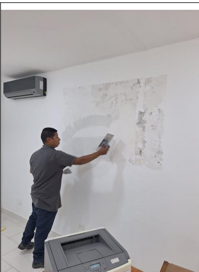
Raspado, estucado, lijado, aplicación de pintura.
